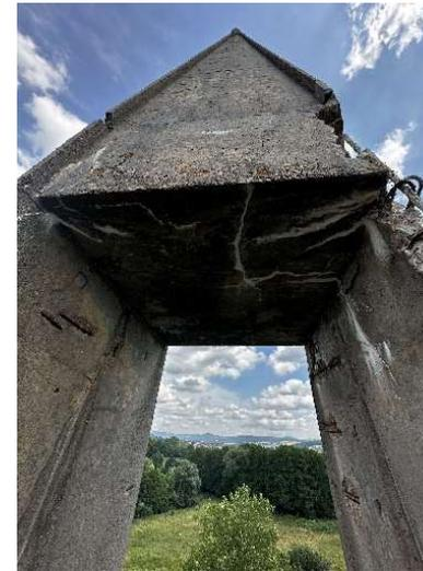
Aktuell finden Arbeiten zur Betonsanierung am Welkerer Glockenturm statt. Leider sind im Zuge der Stemmarbeiten neue Schadstellen im oberen Bereich des Turmes entdeckt worden. Aus Sicherheitsgründen muss das Glockengeläut eingestellt werden, bis die Stabilität des Turmes wiederhergestellt ist. Vielen Dank für Ihr Verständnis!
